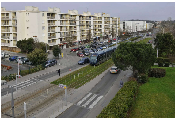
2 Lormont, quartier Génicart (photo Ville de Lormont).
